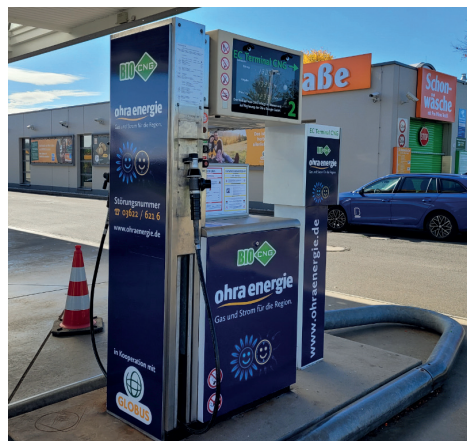
Abb. 29: Beispiel für die Integration einer BioCNG-Tankstelle in einen bestehenden Tankstellenstandort (© Ohra Energie GmbH)
